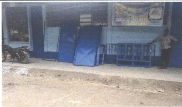
Foto 1: mejoramiento de puerta
