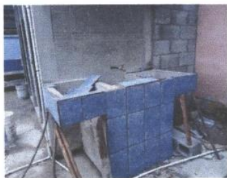
Foto 5: mejoramiento de lavamanos
