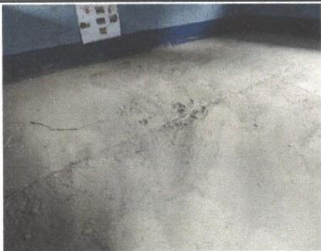
Foto 3: mejoramiento de piso
