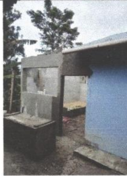
Foto 2: mejoramiento de ventana
