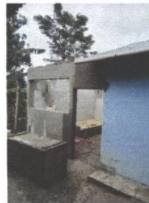
foto 6: mejoramiento de cocina
