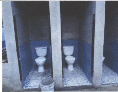
Foto 4: mejoramiento de sanitarios
